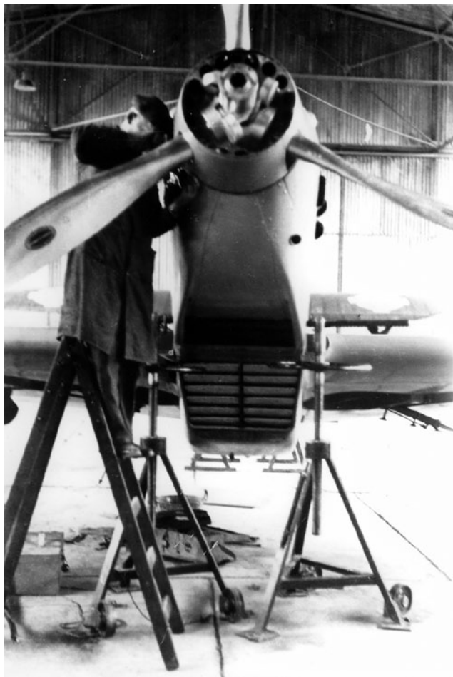
Žorž Šal, mehaničar firme Hispano Suiza snimljen prilikom ugradnje i podešavanja motora HS 12Y29 u prototip aviona IK-3, na aerodromu Zemun, početkom 1938. godine.
